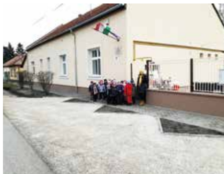
A Rákóczi utcai óvoda felújított parkolója
